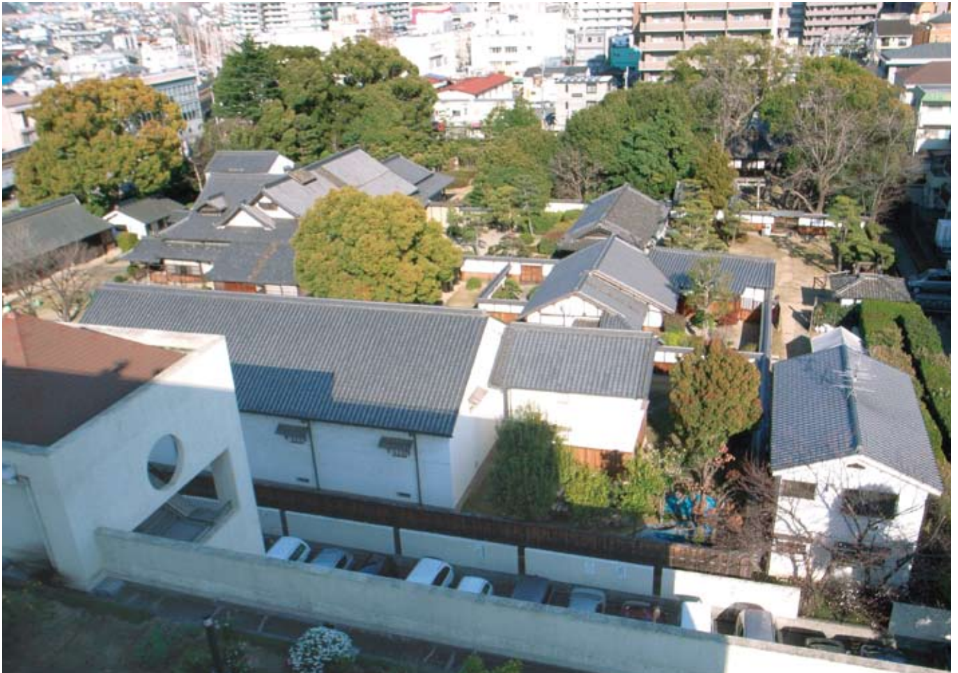
鴻池新田会所全景 (西より)
